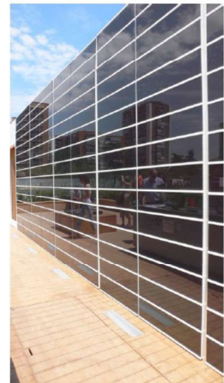
Beispiel 6: Solarthermische Fassade
