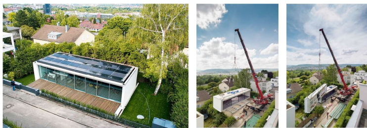
Abb. 1-links: B10 House von Werner Sobek; rechts: Der Transport des "Fliegenden Raumes" modular (Quelle: Werner Sobek, Zooey Braun)
